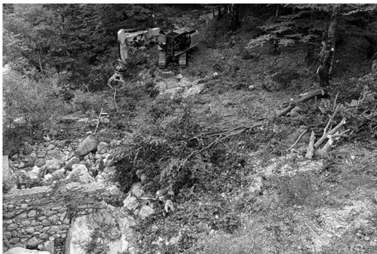
IZVAJALEC DEL JE V PRVI FAZI UREDIL POT DO LOKACIJE, saj je bilo treba dostop do pregrade omogočiti težki gradbeni mehanizaciji. Foto: Hidrotehnik
