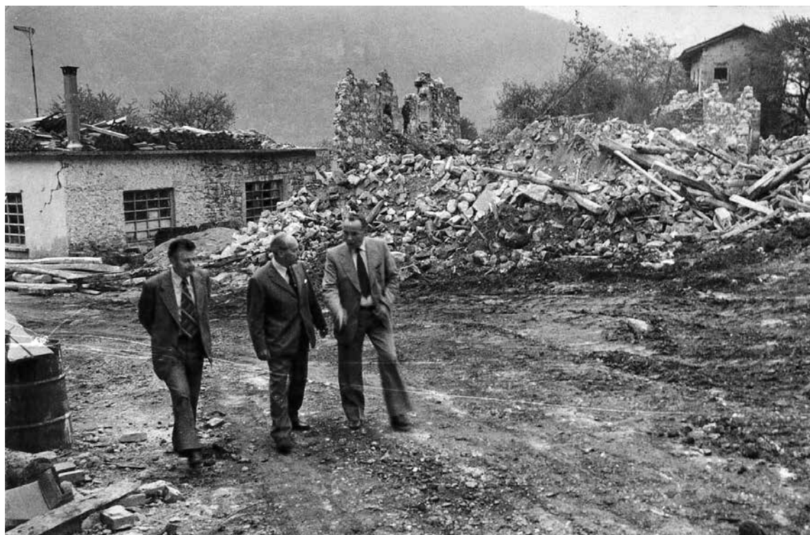
PO POTRESU SO KOMISIJE PREGLEDOVALE HIŠE IN ODLOČALE O OBNOVI ALI RUŠENJU OBJEKTOV, številni lastniki pa soglasja za rušenje zaradi strahu pred zadolževanjem niso želeli podpisati. Foto: osebni arhiv Silve Čušin
