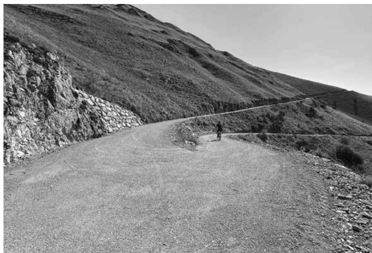
OBČINA KOBARID JE USPEŠNO ZAKLJUČILA SANACIJO 1,7-KILOMETRSKEGA ODSEKA CESTE NA STOL , s čimer je izboljšala varnost, dostopnost in pogoje za trajnostno upravljanje gorskega prostora ter postavila temelje za nadaljnjo obnovo celotne trase. Foto: Občina Kobarid
