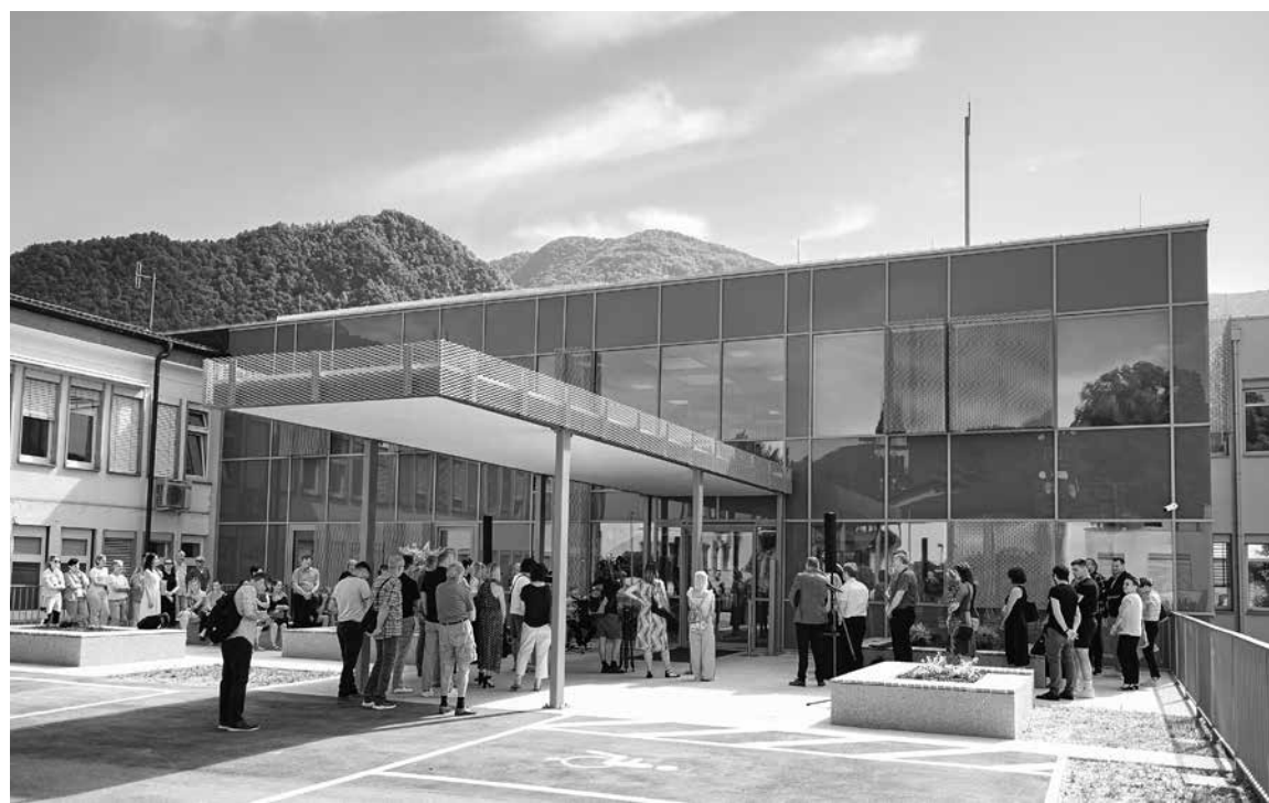
VEČ KOT 10 MILIJONOV EVROV VREDNI NALOŽBI V PRENOVO ZDRAVSTVENEGA DOMA TOLMIN IN GRADNJO SATELITSKEGA URGENTNEGA CENTRA postavljata temelje za dolgoročen razvoj zdravstvene oskrbe v Posočju. Foto: Katarina Rutar Ipavec
