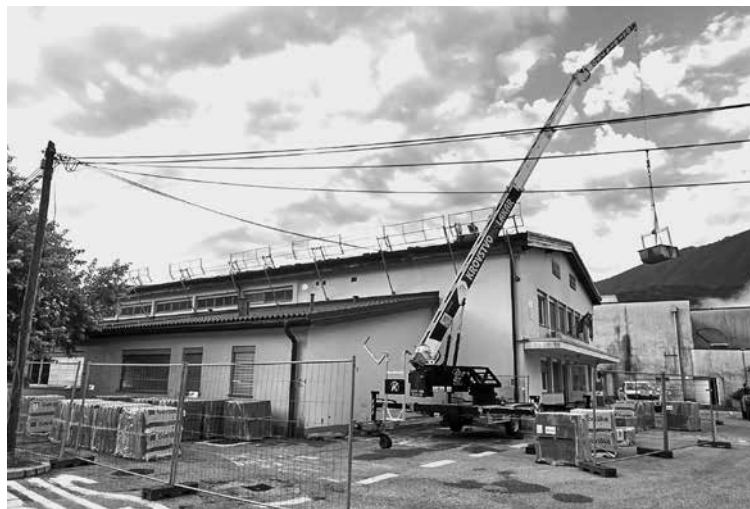
NA OŠ SIMONA GREGORČIČA KOBARID JE ZAKLJUČENA CELOVITA MENJAVA STREŠNE KRITINE , s čimer je Občina Kobarid izboljšala zaščito objekta, njegovo energetske učinkovitost ter zagotovila varnejše in kakovostnejše pogoje za učence in zaposlene.
