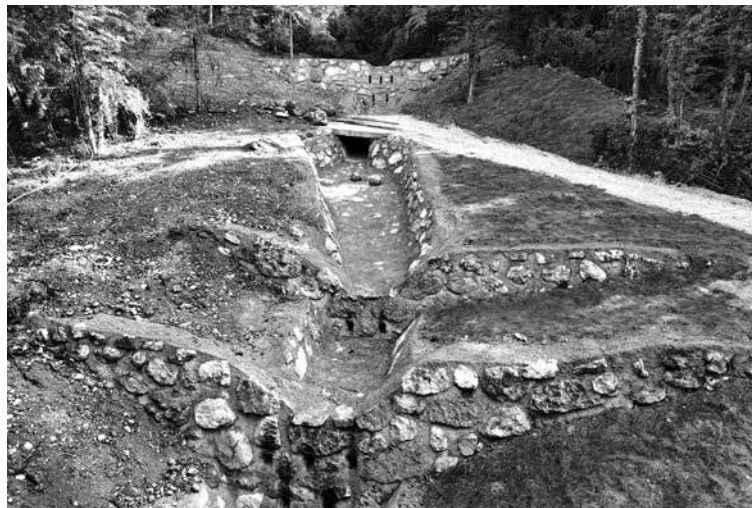
ZAKLJUČEK SANACIJE PLAZU NAD VASJO GABRJE predstavlja izvedbo pomembnega ukrepa za dolgoročno zmanjšanje hudourniške ogroženosti območja ter povečanje varnosti ljudi in premoženja. Foto: arhiv občine
