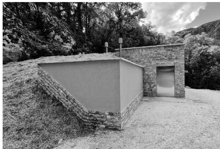
NA TRNOVEM OB SOČI JE ZAKLJUČENA PRVA FAZA PRENOVE VODOVODNEGA SISTEMA Z IZGRADNJO NOVEGA VODOHRANA, ki bo zagotovil zanesljivejšo oskrbo s pitno vodo, manjše vodne izgube in boljšo požarno varnost.
