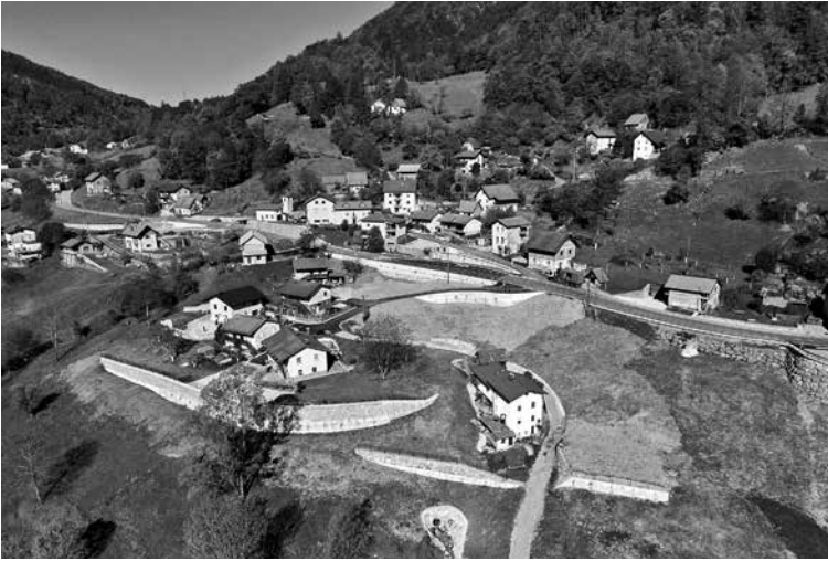
DRUGA FAZA SANACIJE PLAZU NA GRAHOVEM OB BAČI JE USPEŠNO ZAKLJUČENA IN ODSEK ŽE V UPORABI , tretja faza pa je predvidena v prihodnjem letu. Foto: Vid Bizalj
