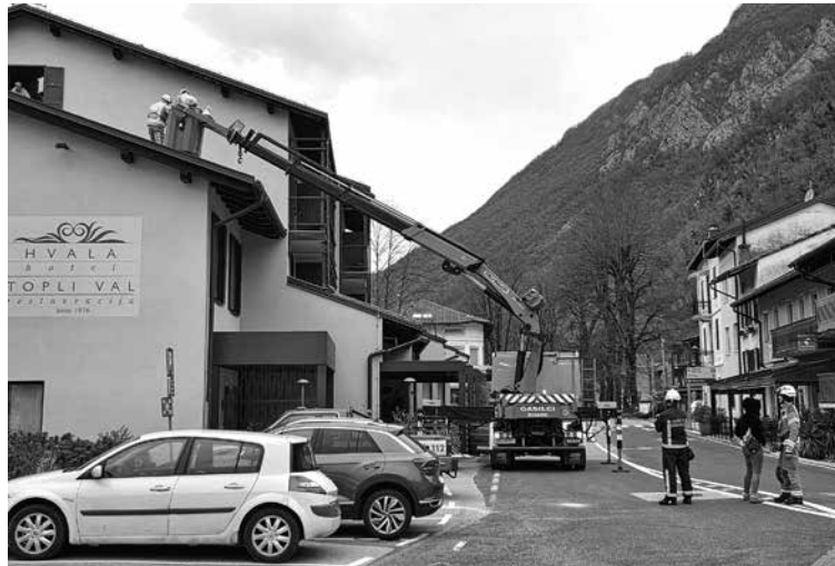
ORKANSKI VETER V OBČINI KOBARID JE POVZROČIL OBSEŽNO ŠKODO, ki je zahtevala hitro in usklajeno intervencijo vseh pristojnih služb. Foto: Občina Kobarid
