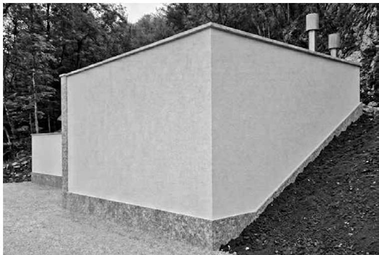
NA TRNOVEM OB SOČI JE BIL MAJA ZGRAJEN NOV 120-KUBIČNI VODOHRAN za izboljšanje oskrbe z neoporečno pitno vodo in zmanjšanje vodnih izgub.
