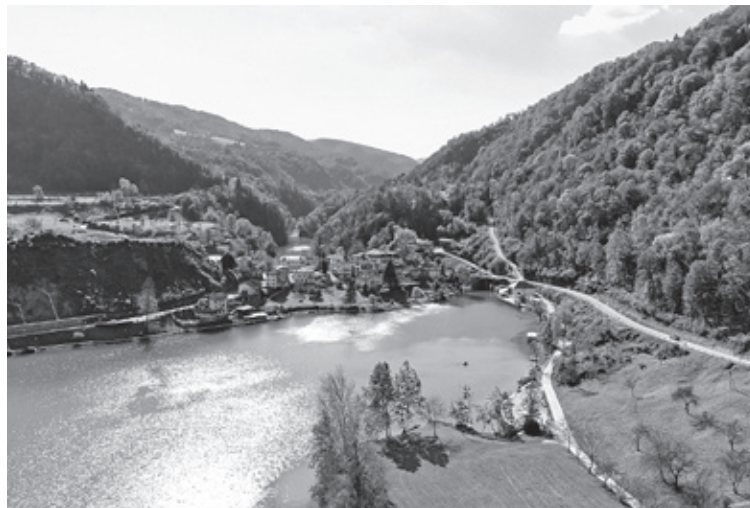
DOTRAJANO KONSTRUKCIJO MOSTA ČEZ SOČO na Mostu na Soči bodo odstranili, nato pa jo nadomestili z novo. Z deli bodo začeli v drugi polovici leta, po koncu turistične sezone. Foto: Andrej Rutar
