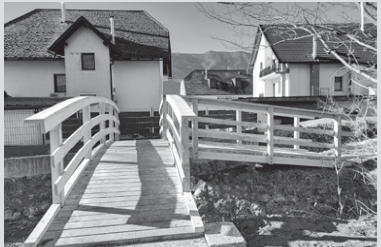
V MALI VASI JE BIL ZGRAJEN NOV MOSTIČEK ČEZ POTOK GEREŠ , ki nadomešča dotrajan in poplavno neustrezen prehod ter prispeva k večji varnosti okoliških objektov.
