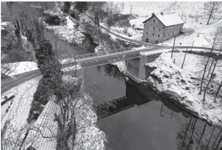
SANACIJA MOSTU ČEZ IDRIJCO NA SLAPU OB IDRIJCI je zajemala celovito obnovo konstrukcije, vozišča in varnostnih elementov. Foto: Vid Bizalj
